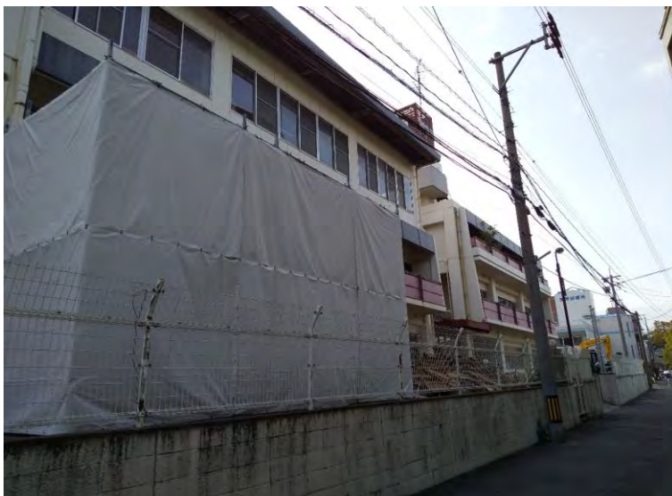
仮囲いが張られています。
