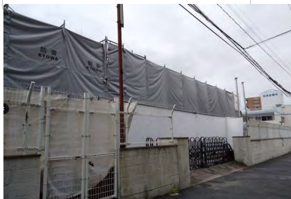
防音シートの内側でどんどん解体しています
