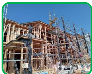
9月の天気がいい日に棟上げを行いました。
