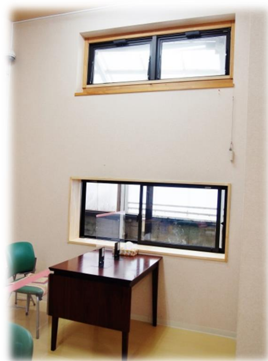
新たに窓の設置
