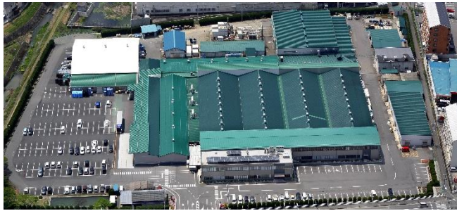
NS ウエスト株式会社庄原本社工場全景
