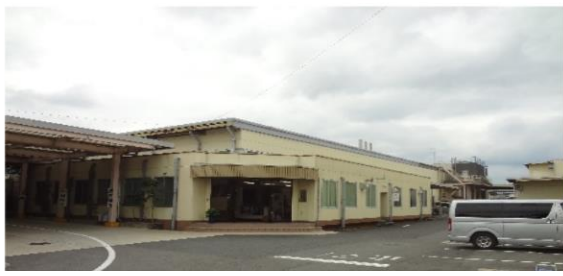
吉舎工場事務所棟を正面から
