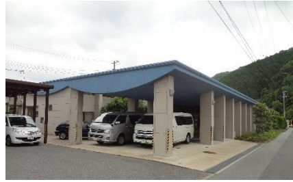
障害者就労センター君田外観
