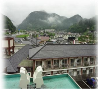
本館屋上から見た特養の建物
