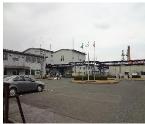
三次工場工場棟
