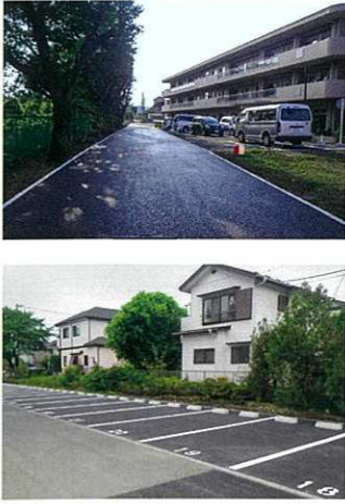
周遊道路、完成
